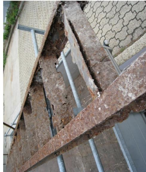
Abb. 53: Oxidierte Leiter, Detail
