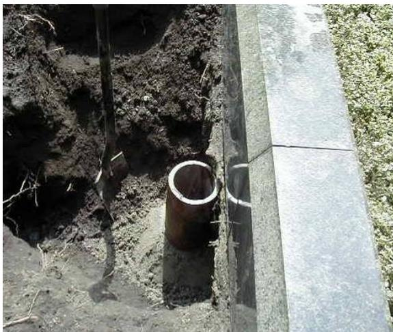
Abb. 48: Lüftungsrohr freigelegt, jedoch noch ohne Haube
