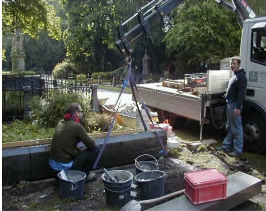
Abb. 29: Versetzen der Einfassung mit dem LKW-Kran
