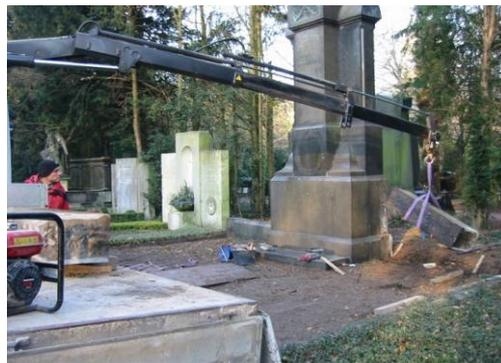
Abb. 16: Anheben eines Quaders mit dem LKW-Kran
