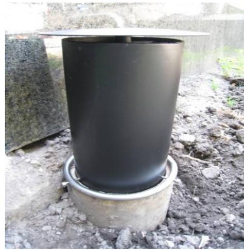
Abb. 49: Lüftungsrohr mit neuer Haube
