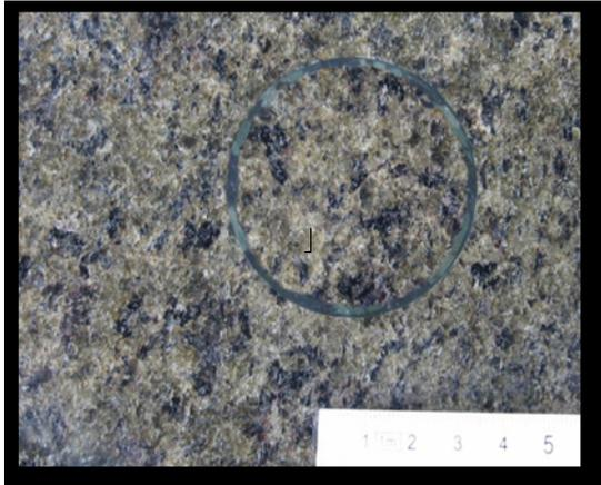
Abb. 19: Bohrkernergänzung
