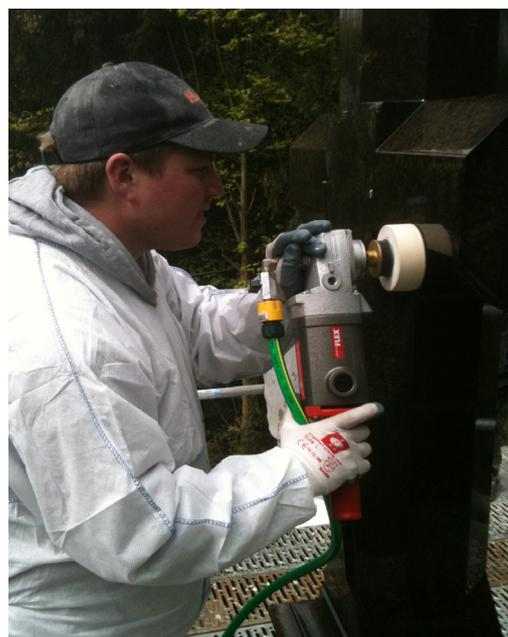
Abb. 31: Polieren des bekrönenden Kreuzes mit einem Filzpolierkopf
