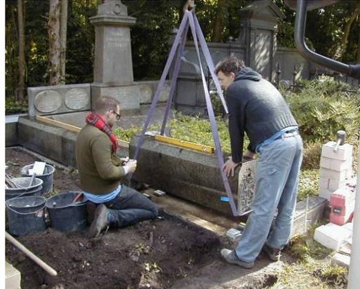
Abb. 30: Ausrichten der Einfassung
