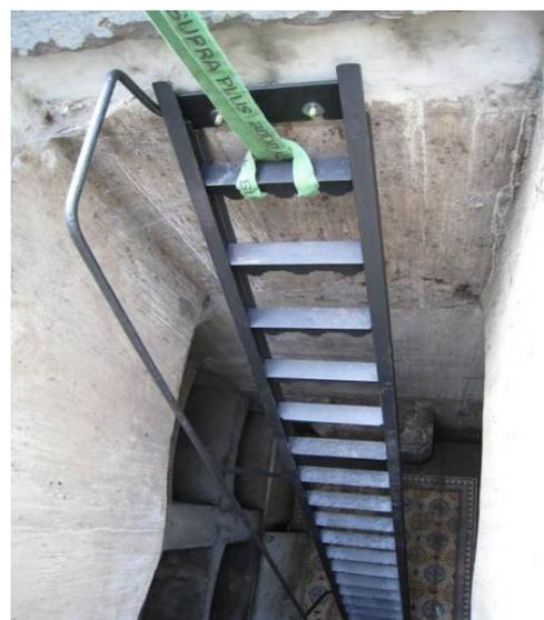
Abb. 55: Oberer Teil der Leiter mit neuer Verankerung, Ergänzungen und Rostschutz
